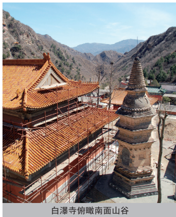
白瀑寺俯瞰南面山谷
