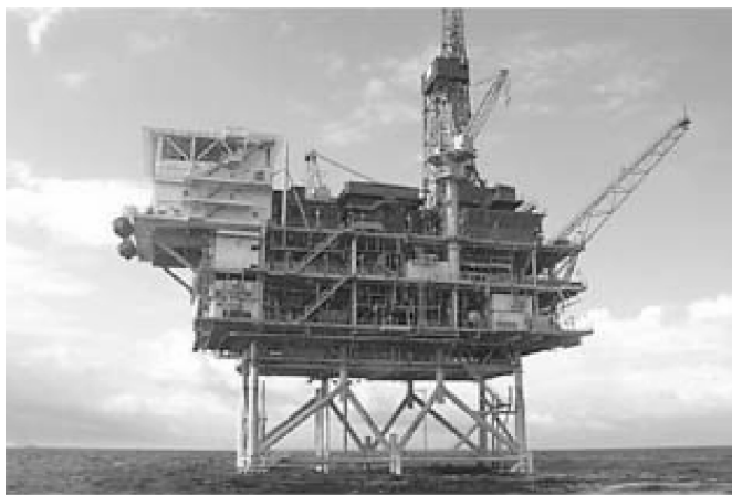
图 1-12 东海某固定式采油平台
