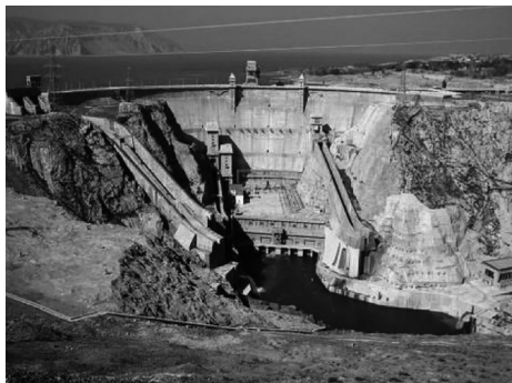
图 1-9 龙羊峡水电站
