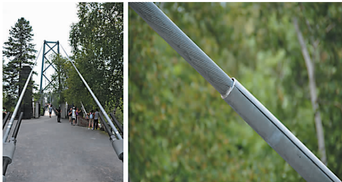
图 2-1 悬索桥承受拉力的钢缆
