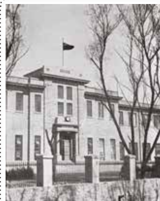
机械工程系馆，1934年建成。
