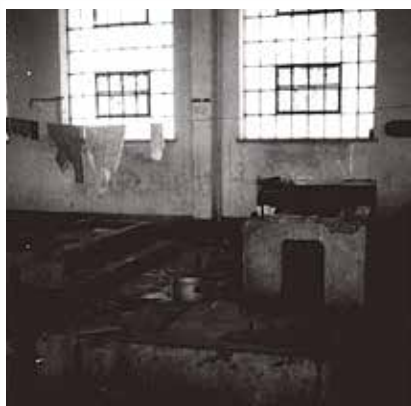
机械馆内仪器设备荡然无存仅剩机座。
