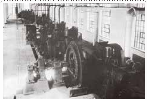
热力工程实验室
