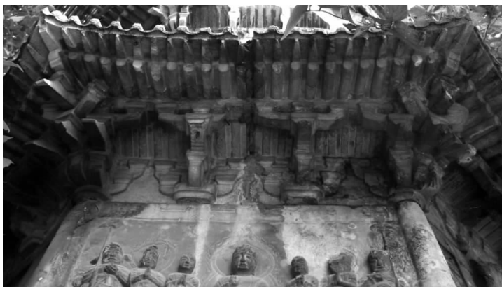
图 14 杭州灵隐寺石塔扶壁拱形式
