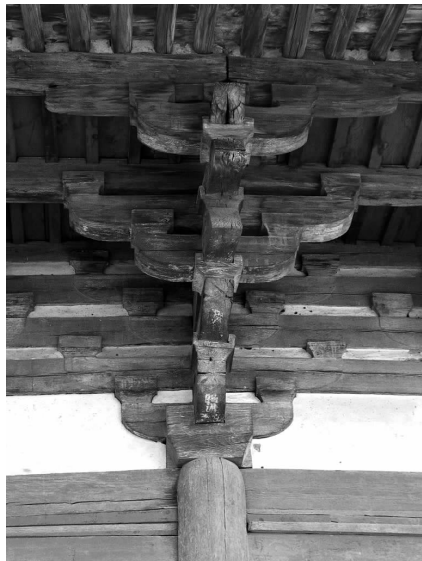
图 8 佛光寺大殿外檐扶壁拱形式
