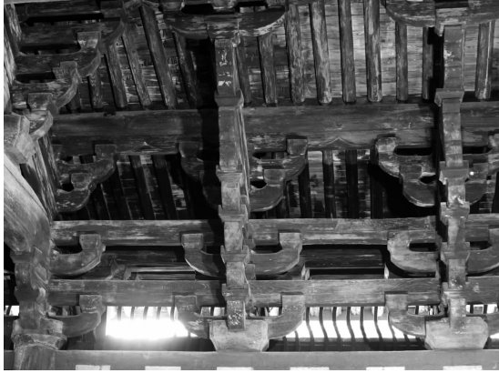
图1 大殿外檐扶壁拱形象(东山中进间)
