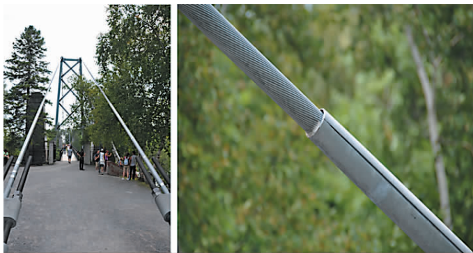
图 2-1 悬索桥承受拉力的钢缆
