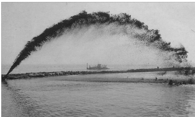
图 1.13 河北省曹妃甸的吹沙船在吹沙造地、吹起的沙形成近似抛物线
