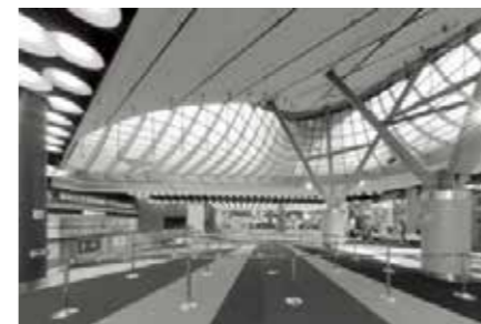
图 2-81 上海港国际客运中心航站楼，2011
