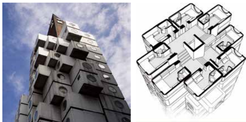
图2-50 日本中银胶囊大楼，1972
