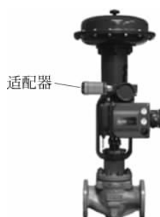
图 3-6 使用适配器访问设备的诊断信息
