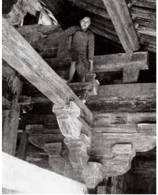
1933年林徽因在正定开元寺钟楼梁架上
