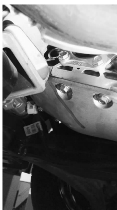
图 3-1-7 变速器油渗出油位检查孔塞
