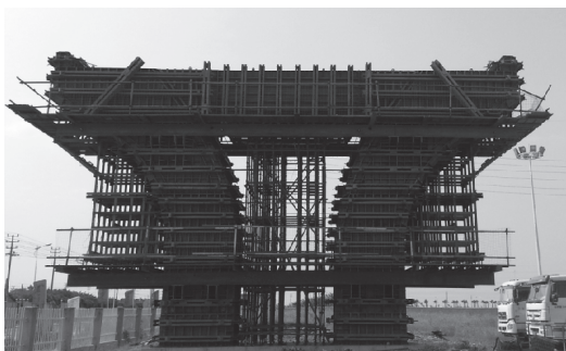
图 9 模板及支架施工图
