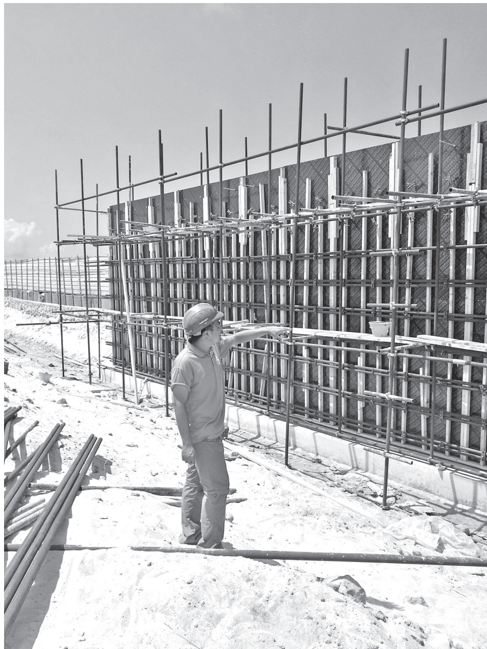
2017年4月17日，中国驻索马里大使馆馆舍建设工地上，曹江伟在工作
