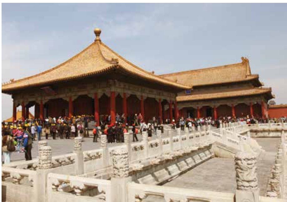
图 1-2-7 故宫三大殿中的中和殿、保和殿
