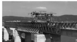
箱梁阶段拼装造桥机
