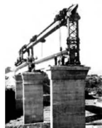
20世纪60年代筒支梁式架桥机
