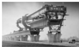
32 m/900 t箱梁架桥机
