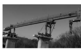
32 m/180 t T型梁架桥机
