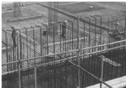
(b) 施工现场
