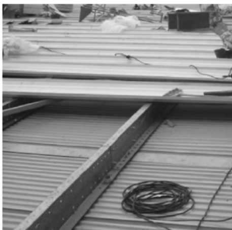
图 1-12 钢屋架屋面结构板
