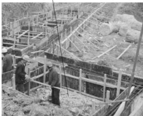
图 1-10 基础加固
