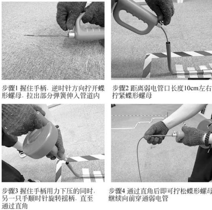
图 5-6 橄榄头弹簧穿管器安装过程
