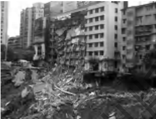
图 1-6 广州某基坑倒塌事故现场照片
