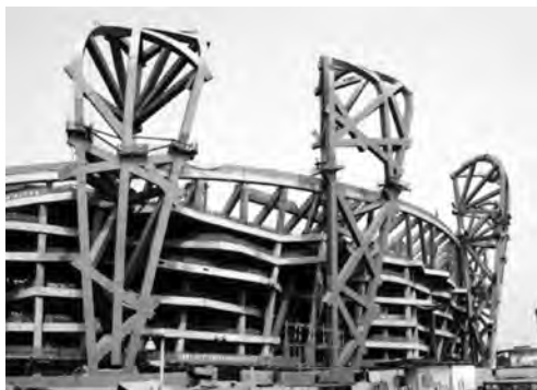
图 1-5 正在施工中的建筑(局部)
