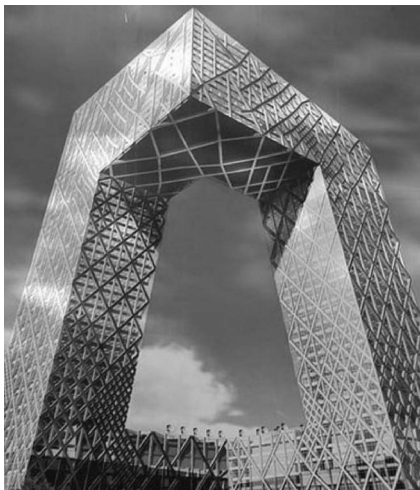
图 0-8 中央电视台总部大楼
