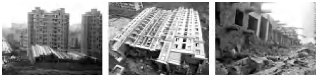
图 1.5 上海“莲花河畔景苑”在建楼房整体倒塌
