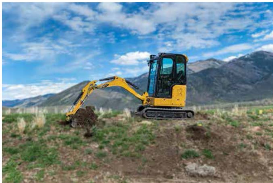
作业中的卡特彼勒 302 CR 挖掘机
