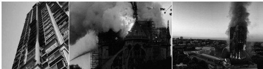
图 1.3 2022 年四川内江商住楼大火、2019 年巴黎圣母院大火和 2017 年格伦费尔塔公寓楼大火
