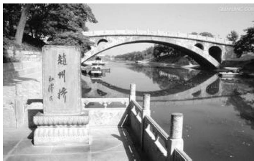
图 1-7 河北赵县安济桥(又称赵州桥)
