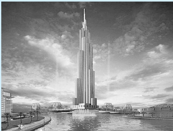
图 1-4 哈利法塔(迪拜塔)
