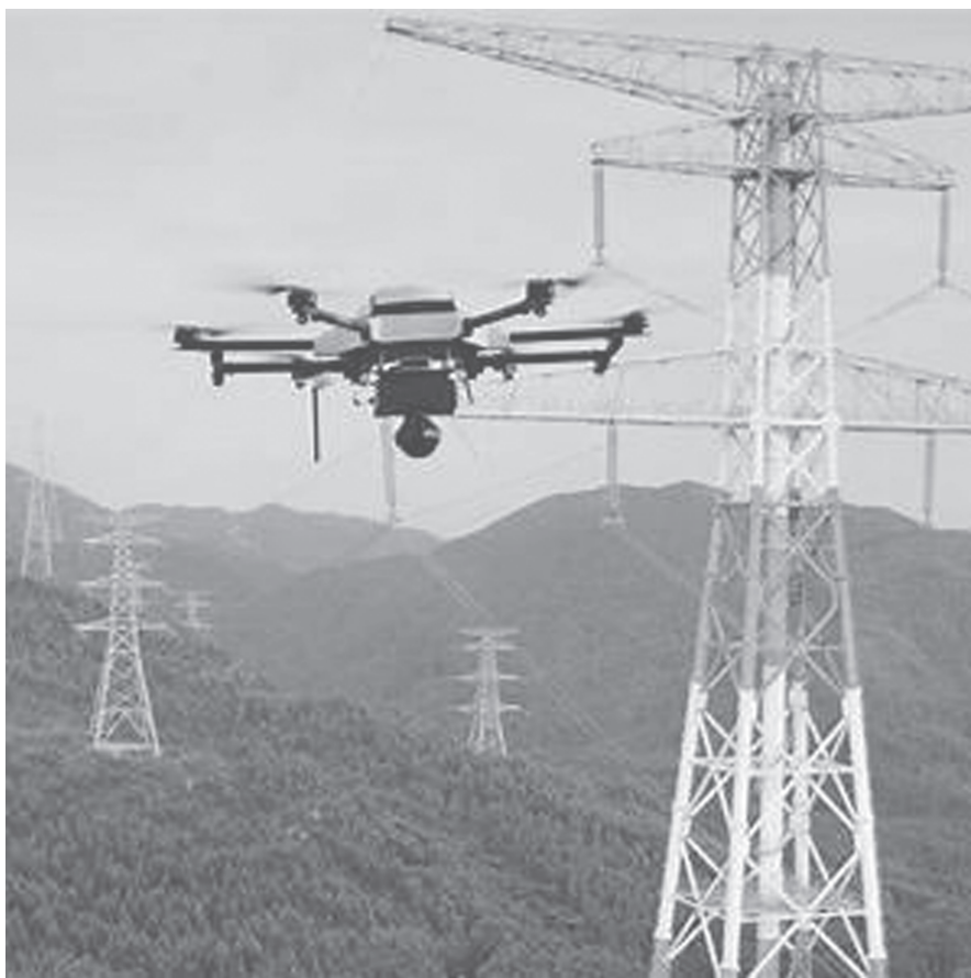
图 1.12 无人机电力巡检
