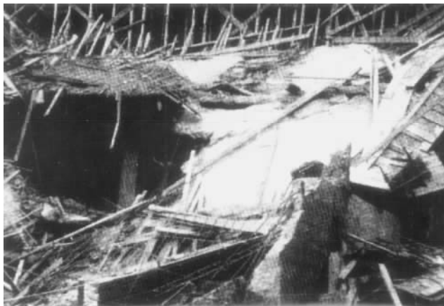
图 0.17 国外一座厚板结构楼倒塌 [12]
