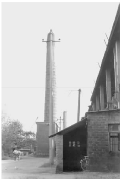
图 0.3 南昌钢铁厂烟囱倾斜
