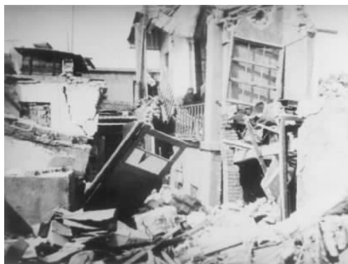
图 0.16 徐州市区发生塌陷 (刘成华摄)
