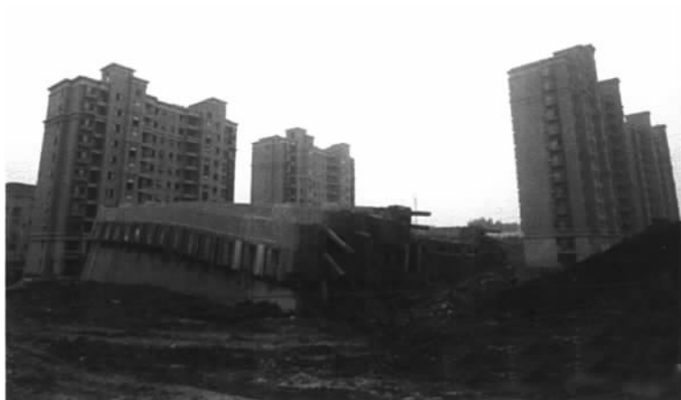
图 0.14 上海闵行莲花河畔景苑小区一栋楼房倒塌(图片来源:新浪网)
