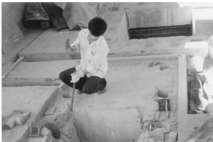
图 0.11 北京大学汽轮机基座处理
