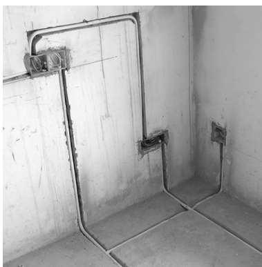
图 3-6 直接埋管布线施工图
