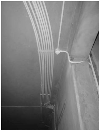
图 3-8 吊顶布线施工图
