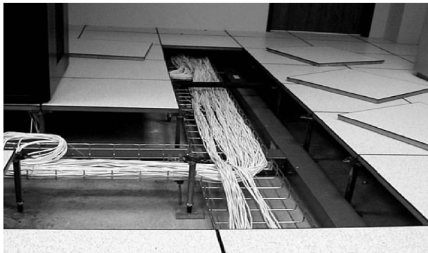
图 3-10 地面槽线布线施工图
