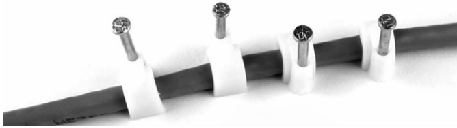
图 5-7 使用卡线钉对网线进行固定
