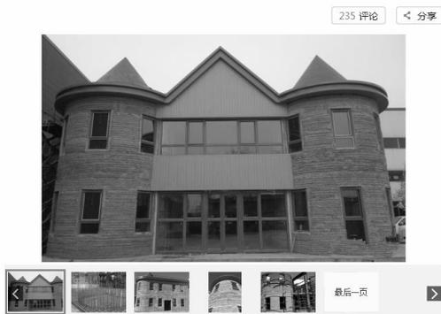
近日，在北京通州的一个厂房内，诞生了世界上第一个用3D打印机打印的房屋，与之前国内外的3D打印建筑不同的是，这个别墅是打印机现场打印的，而不是提前打印好然后拼接。
