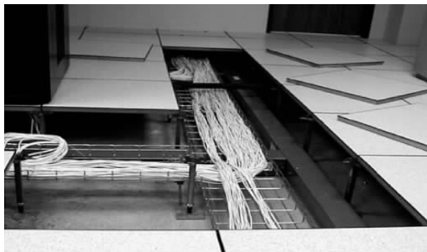
图 3-10 地面槽线布线施工图
