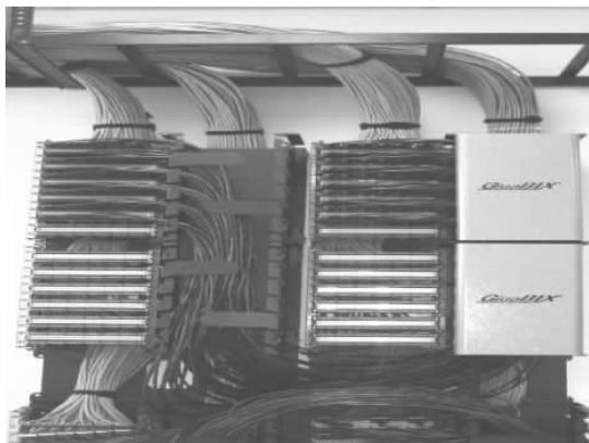
图 3-20 梯架式槽道实例图
