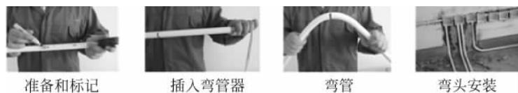
图 3-28 使用弯管器制作拐弯示意图
