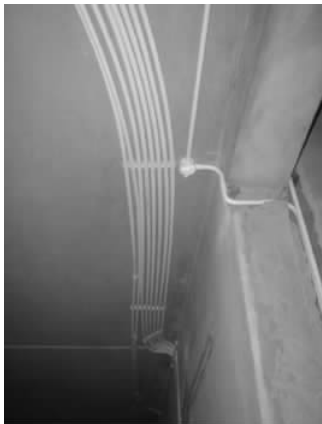
图 3-8 吊顶布线施工图
