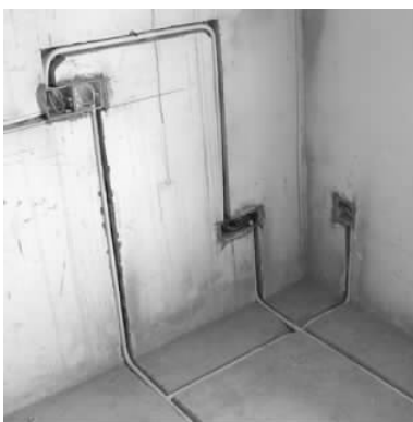
图 3-6 直接埋管布线施工图
