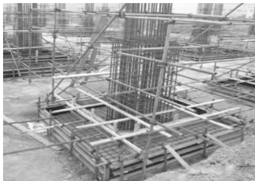
图 3-4 阶梯形基础模板(二)
