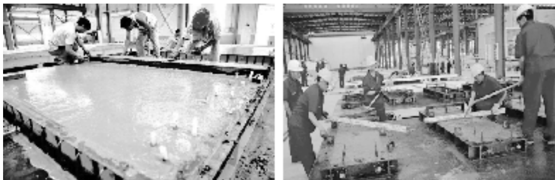
图 1-5 PC 构件表面平整抹光
