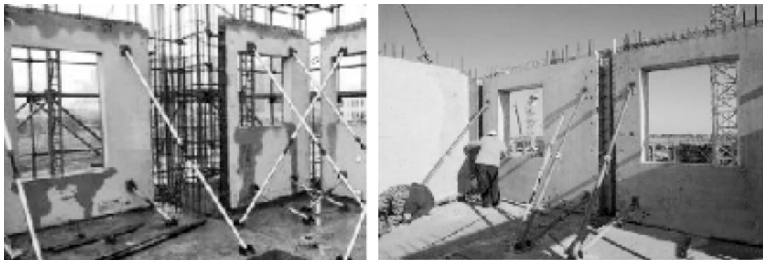
图 1-10 PC 墙板支撑固定
