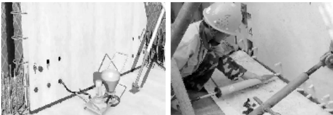
图 1-11 PC 构件注浆连接
