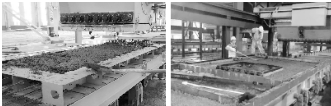
图 1-4 浇捣 PC 构件混凝土
