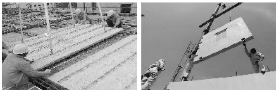
图 1-9 PC 构件吊装
