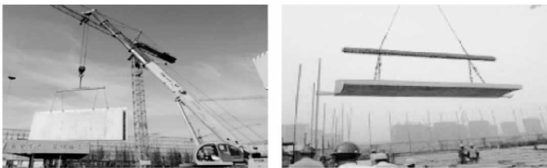
图 1-3 预制构件机械化施工
