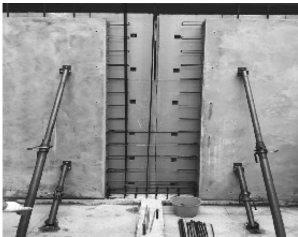
图 1-1 装配整体式剪力墙结构
