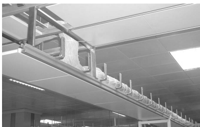
图 2.44 大跨距电缆桥架
